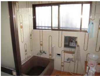
ห้องอาบน้ำ
